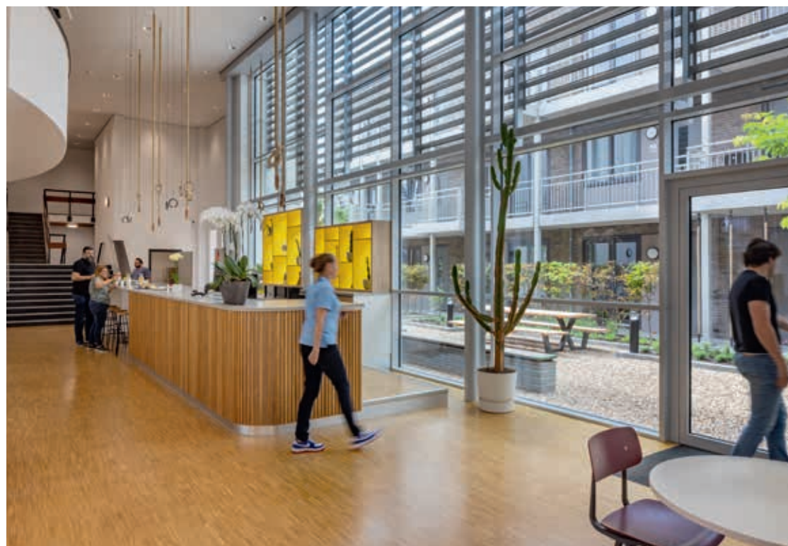
FOTO ONDER Waar de gesloopte gymzaal aansluit op de aula is een nieuwe hoge glazen pui geplaatst, waardoor een serreachtige ruimte is ontstaan met uitzicht op de binnentuin.
